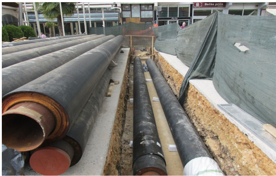
Fotografija: Izmještanje dijela toplovoda u blizini slastičarne "Palma".
