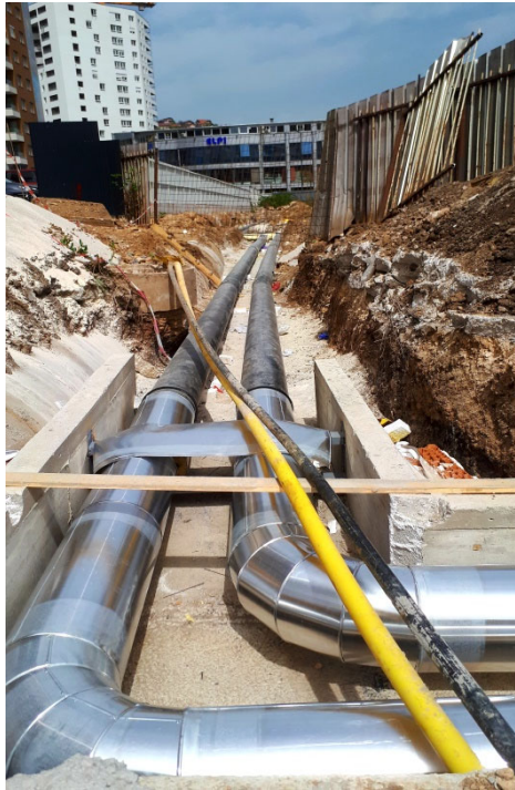
Fotografija: Radovi na priključenju stambeno-poslovnog objekta „Dijamant“.
